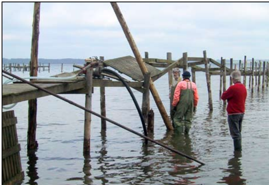
Tidligere hårdt arbejde med at få broen på plads
